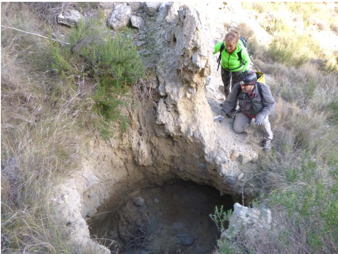
Figura 21. Entre las simas 04 y 05, a lo largo del cauce del barranco se encuentran varias depresiones de 2-3 m, cegadas por sedimentos, y pipes menores. Ello indica que existen circulaciones subterráneas bajo el cauce.
